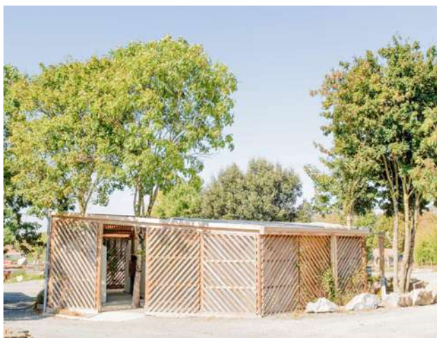
Les sanitaires sont réalisés sous la forme de cabanon répartis dans la halle
