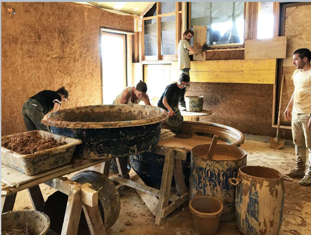
Chantier de formation pour la réalisation de murs en terre allégée et enduits terre pour une école
