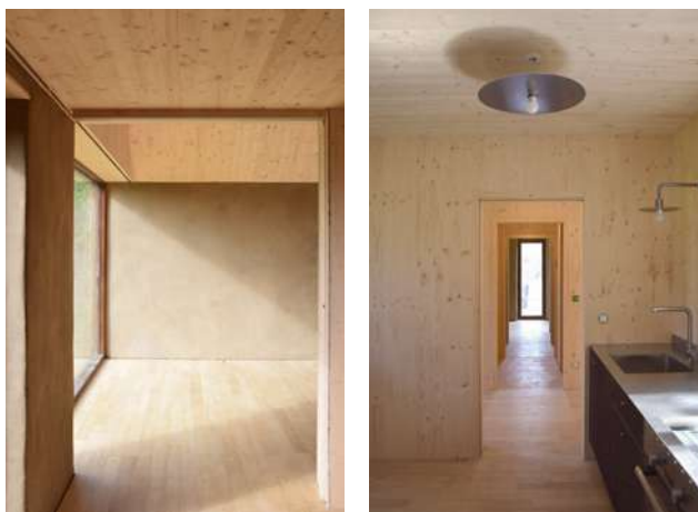
Les terres excavées du site sont appliquées en enduits intérieurs sur l'isolation paille
