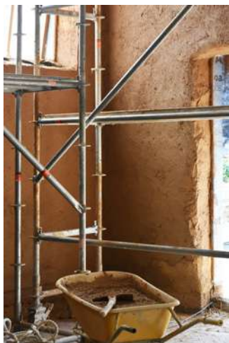
Sur le chantier, charpente bois, isolation paille, enduits terre, couverture ardoise sont mis en oeuvre par les artisans
